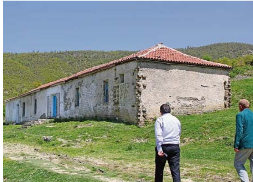
Gesamtansicht von vorne: 9-Jahres-Schule und Ambulanzstation in Senican in Südalbanien.
